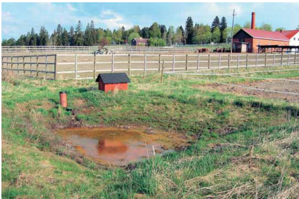
Kuva 19. B-pihaton tarhavesien puhdistamo Ypäjällä. Vuoden seurantajakson keskiarvoina tulevan veden liuenneen fosforin pitoisuus oli 1,9 mg/l ja lähtevän veden 0,09 mg/l. Kokonaisfosforipitoisuus tulevassa vedessä oli 2,4 mg/l ja lähtevässä vedessä 0,4 mg/l. Fosforipitoisuudet ovat puhdistamon avulla laskeneet Suomen pelloilta valuvien vesien vastaavien pitoisuuksien tasolle. Kuva on otettu toukokuussa 2006.
