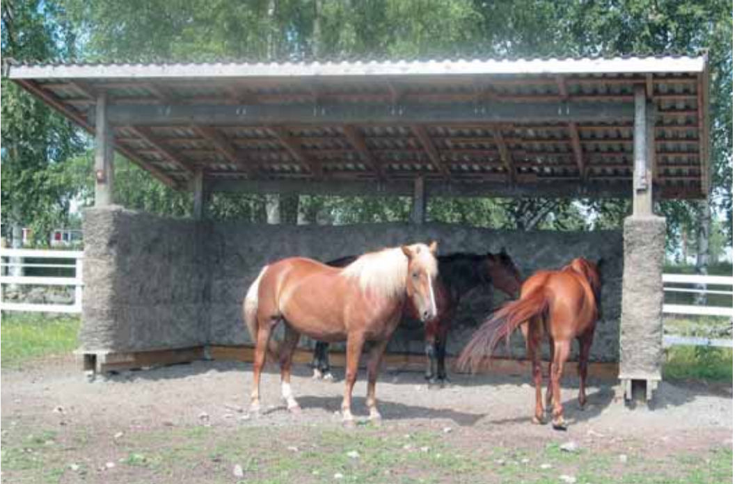
Kuva 20. EquineLife-hankkeen puitteissa rakennettiin Ypäjän Päivärinteessä tarhattaville savi-olkiseimäinen sääsuoja. Suojan työselitys löytyy osoitteesta www.equinelifi.fi .
